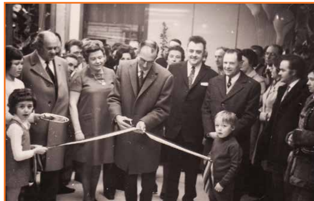
Ichtegem 1973: opening wasserij Moderna.
