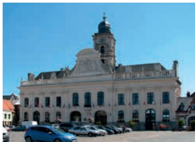
Het monumentale stadhuis met belfort
